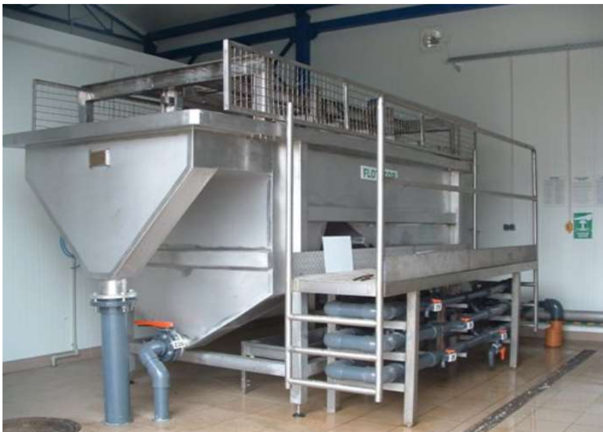
Rysunek 25. Flotator wykorzystywany przy podczyszczaniu ścieków przemysłu rybnego (projekt i wykonanie firma EKOBUDEX z Gdańska)
