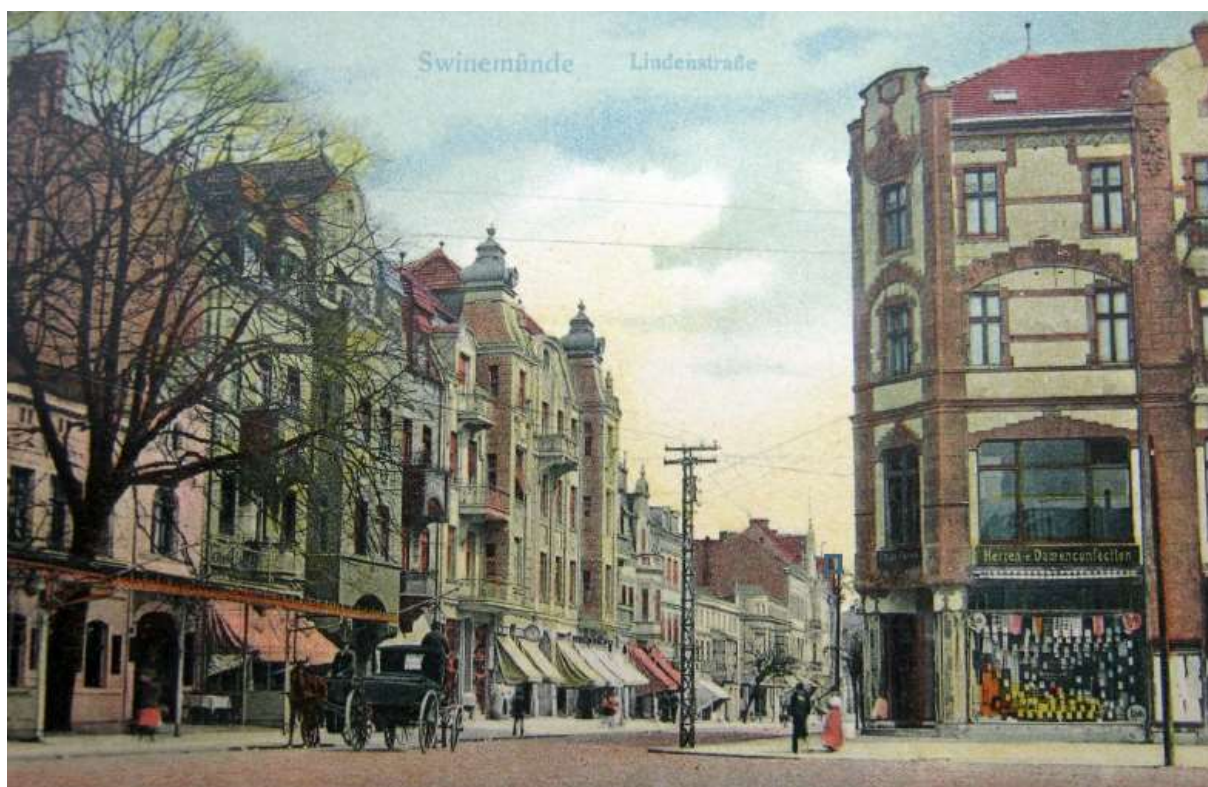
Rysunek 72. Na starych zdjęciach z roku 1910 i 1929 widać, jaką budynek był perełką architektoniczną
